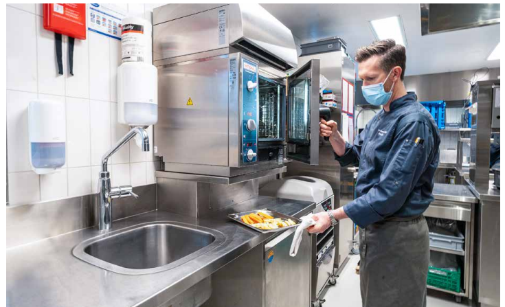
Clever: Die Combi-Dämpfer stehen auf zurückversetzten Stützen, so dass darunter noch Ablagefläche bleibt.
