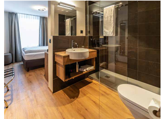
Die Hotelzimmer hat die Gschwend AG Gastro-Bau energetisch saniert und mit offenen Nasszellen das Optimum aus den kleinen Räumen herausgeholt.
