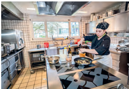
Im Dezember 2021 wurde die Herdanlage in der Küche des Restaurants Auenstube ersetzt, neu mit vier Induktionskochfeldern. Im Bild: Sara Wiedenmeier, die zusammen mit Pascal Jacky die Gäste in der Auenstube bekocht.
